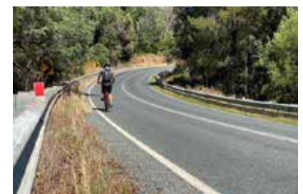
Boggy Creek Rd diversion
